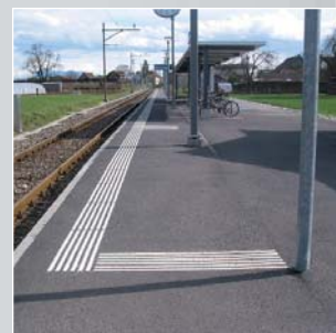
Aménagement de fins de perrons
